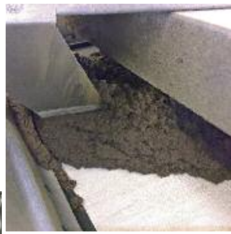
Fango in uscita dal preaddensatore Sludge leaving the pre-thickener
